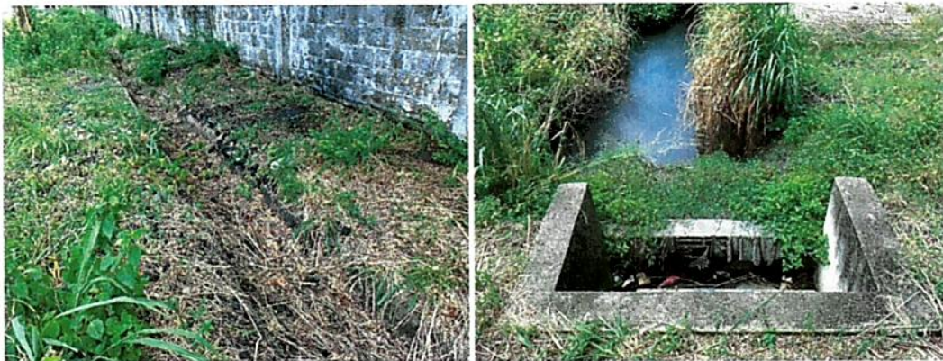
Figura 5 - Canaleta e filtro em alvenaria
