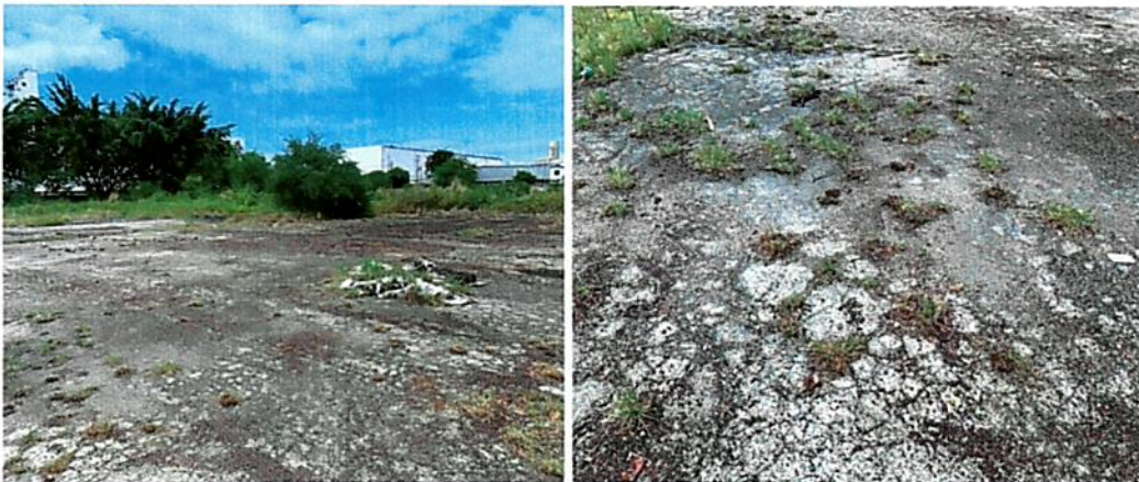
Figura 2 - Piso do Pátio 01B
