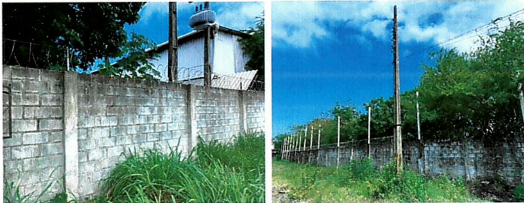
Figura 4 - Muro em bloco de concreto pré-moldados e postes de rede elétrica
