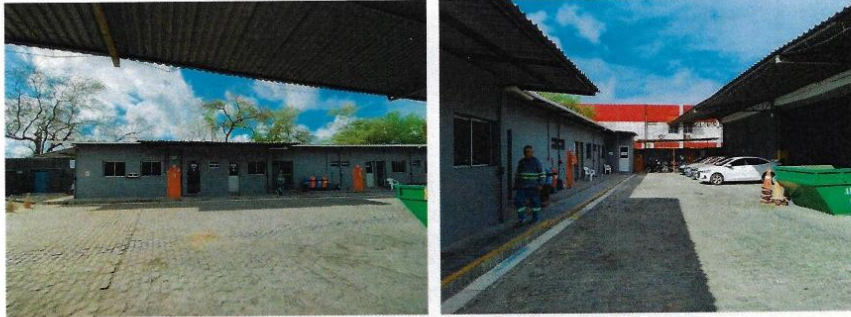
Figura 8 - Área administrativa e de estacionamento
