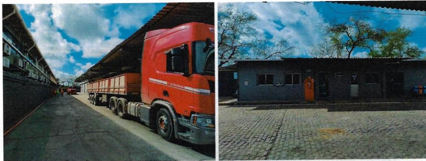
Figura 2 - Piso do Pátio
