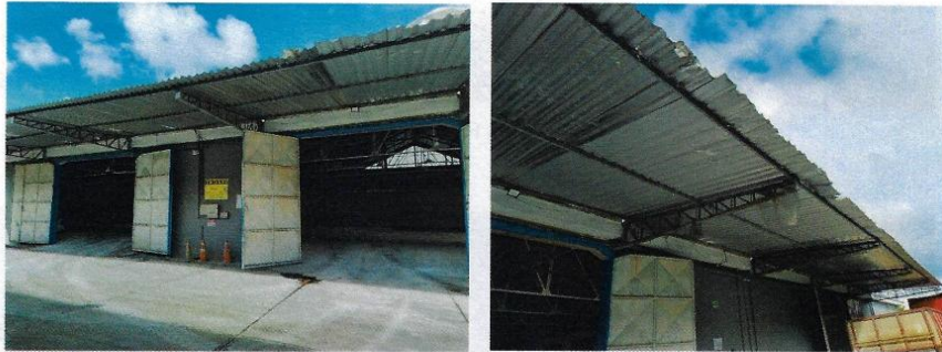
Figura 6 - Portões e cobertura do galpão.
