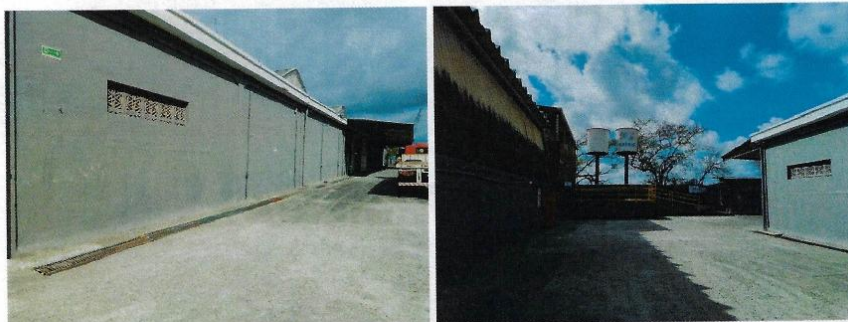
Figura 3 - Canaleta e Caixa d'água no Pátio
