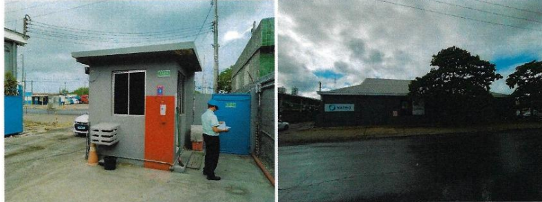
Figura 13 - Guarita e fachada externa do galpão
