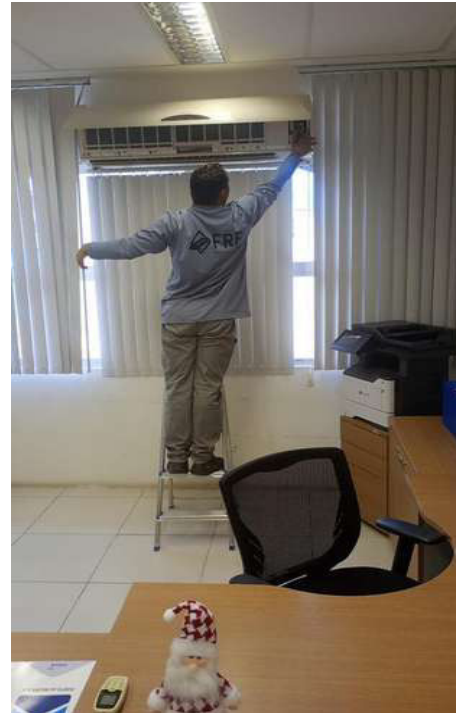
Figura 18: Substituição de Ar condicionado.
