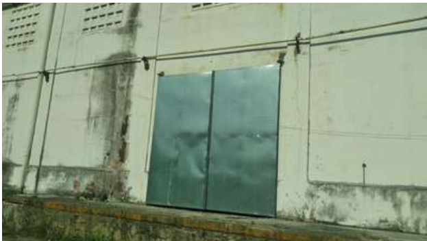
Figura 29: Portões novos do Armazém 08.
