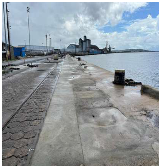
Figura 10: Revitalização do piso
