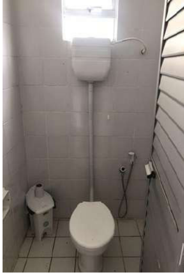
Figura 31: Instalação de caixa de descarga de 9L
