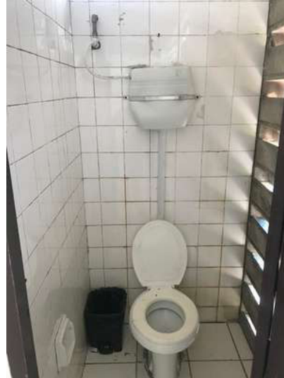
Figura 32: Troca de assento sanitário e caixa de descarga.
