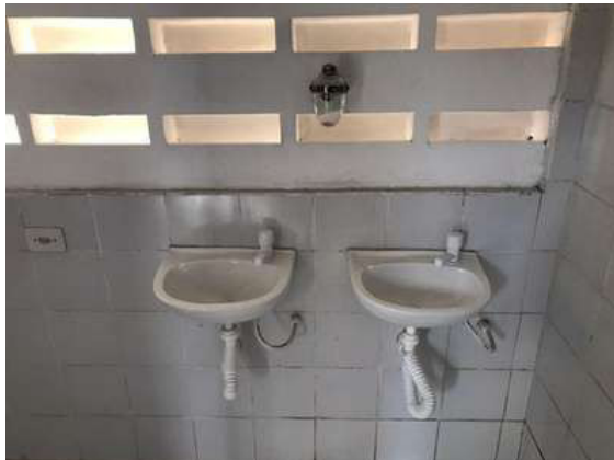
Figura 33: Instalação de sifões e torneiras.
