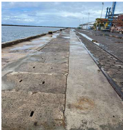
Figura 9: Revitalização do piso
