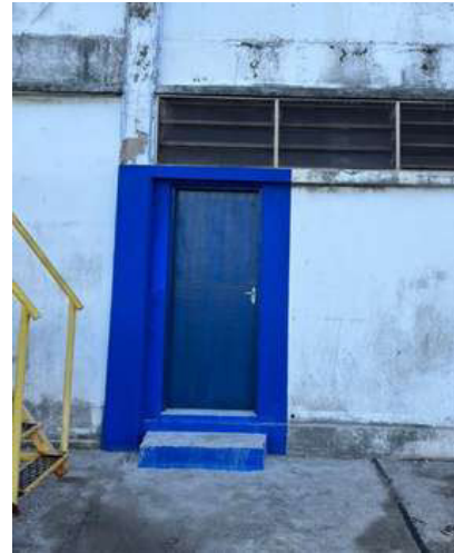
Figura 28: Ponto de Apoio 3: Cais 05
