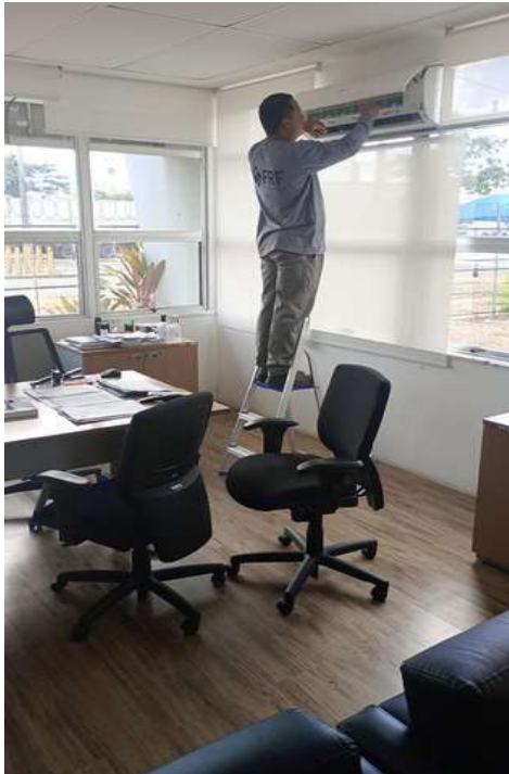
Figura 17: Substituição de Ar condicionado.
