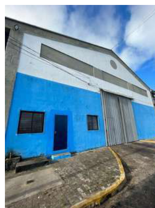
Figura 24: Ponto de Apoio 1: Cais 02
