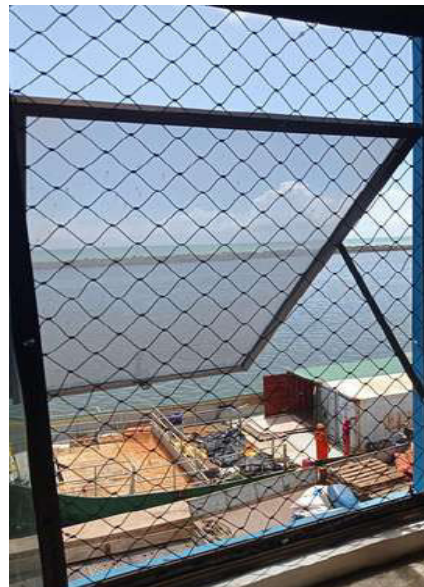
Figura 14: Tela instalada em janela.
