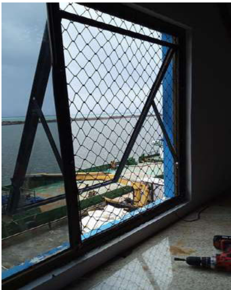
Figura 13: Tela instalada em janela.
