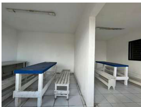
Figura 23: Ponto de Apoio 1: Cais 02
