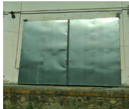
Figura 30:Portões novos do Armazém 08.
