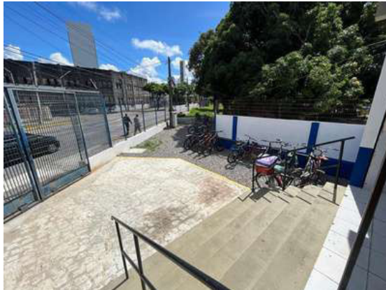
Figura 5: Nova pavimentação e instalação de novo corrimão.
