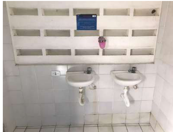
Figura 34: Instalação de sifões.
