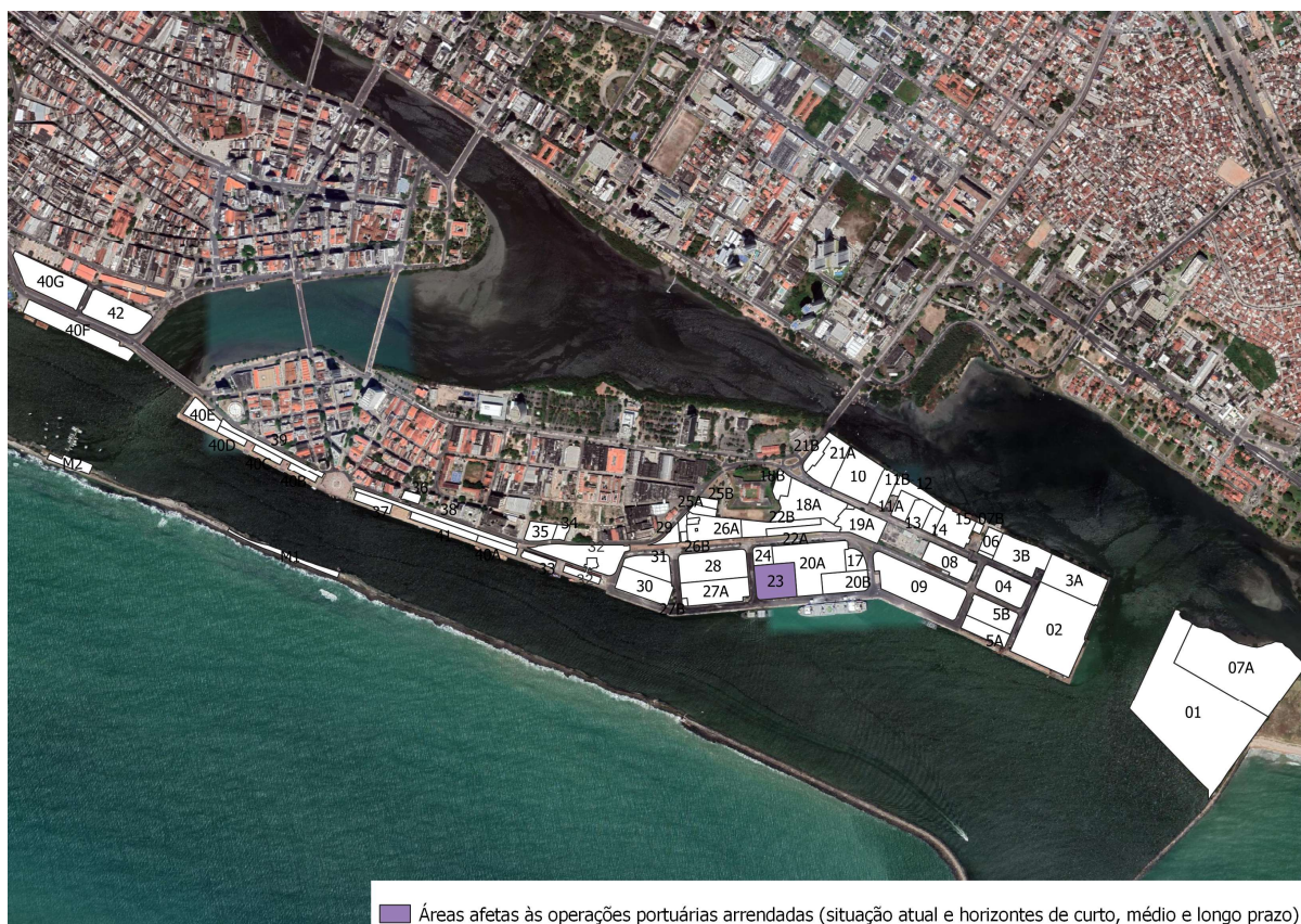
Figura 15: Áreas e instalações afetas às operações portuárias arrendadas
