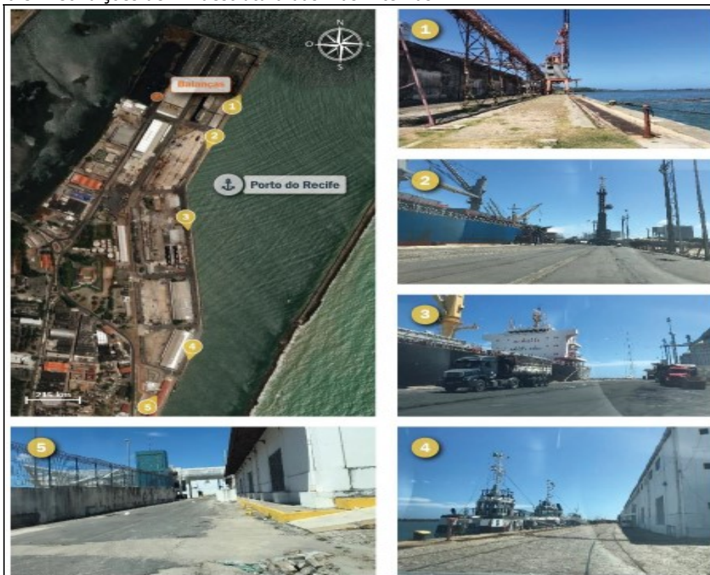
Figura 32: Condições de Infraestrutura das Vias Internas
