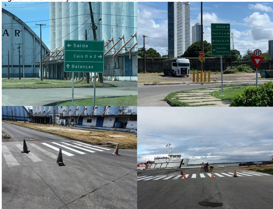
Figura 48: Sinalização horizontal e vertical
